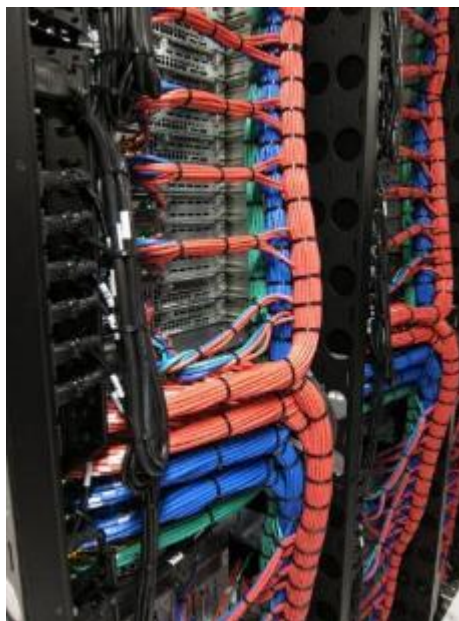
サーバの冷却を妨げない配線
